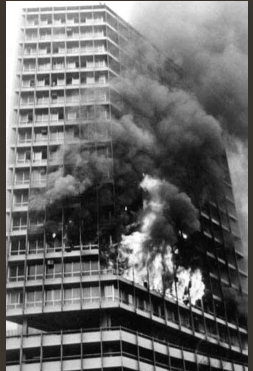
Imagem: Edifício Andraus - 1972
